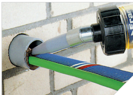
2. Pres HyDra® Sealant mod bagstoppet til en lagtykkelse på minimum 50 mm opnås.
