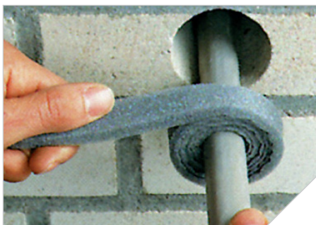
1. Montér bagstop på rør/kabel.
